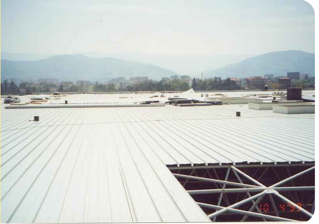
Resim 5.4 Çatı trapezi uygulaması
