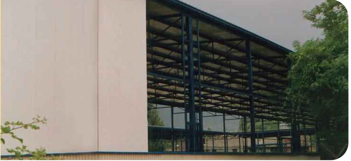
Resim 5.20 Poliüretan Cephe Paneli Düşey uygulaması
