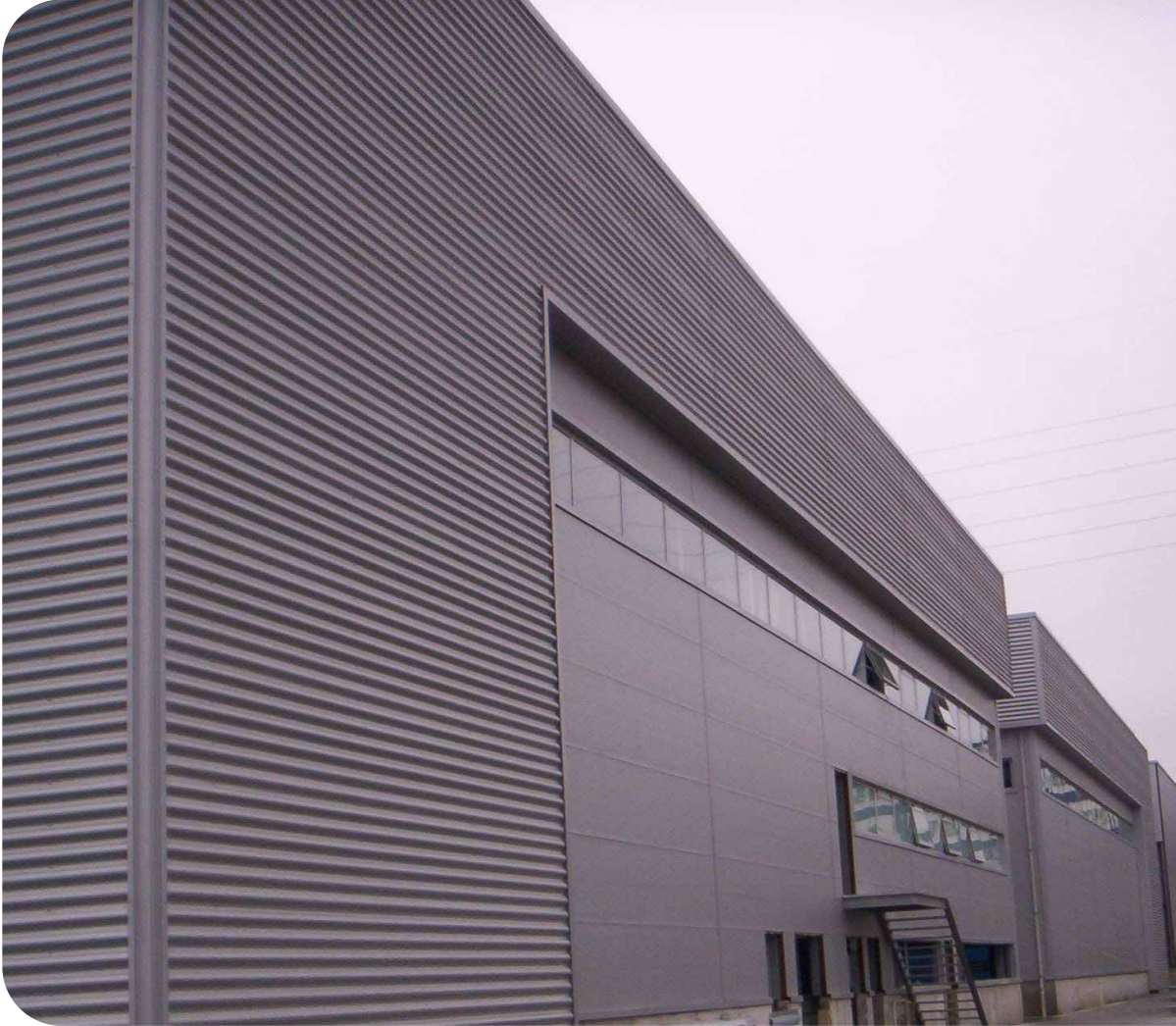
Resim 5.23 Yerinde uygulama ön yüz yatay uygulama
