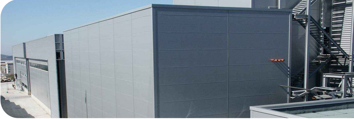
Resim 5.18 Yatay cephe paneli uygulaması
