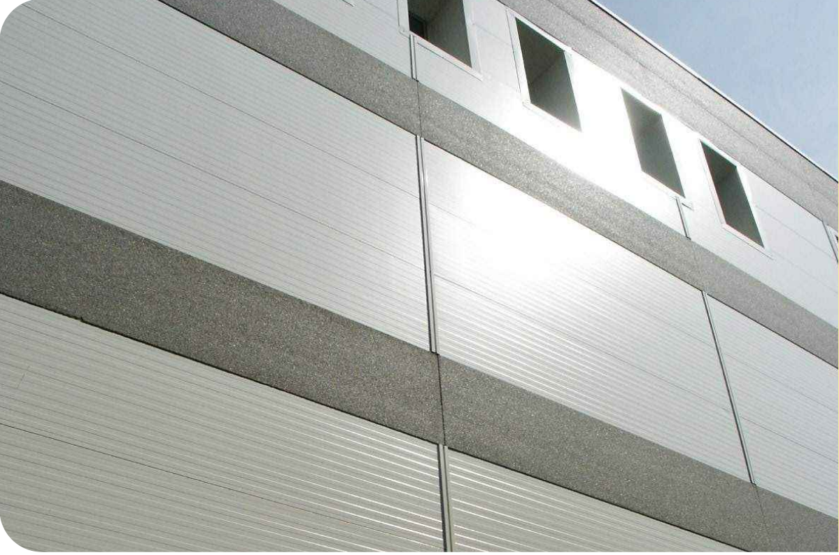
Resim 5.21 Poliüretan cephe paneli yatay uygulaması
